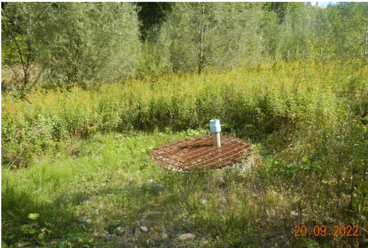
Messstelle Schacht 1 (Sammelschacht – S1)
